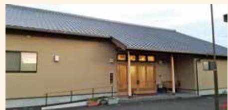
令和2年3月に開所した小規模多機能型居宅介護「創生館」 都城市庄内町8618番地1 TEL36-5103
